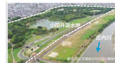
整備事例：愛知県 庄内緑地（小田井遊水地）
