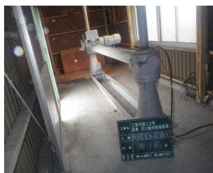
図-1.9 前の川逆水樋門の老朽化対策（左 修繕前、右 H29 修繕後）
