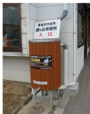
貯留・浸透施設の設置
