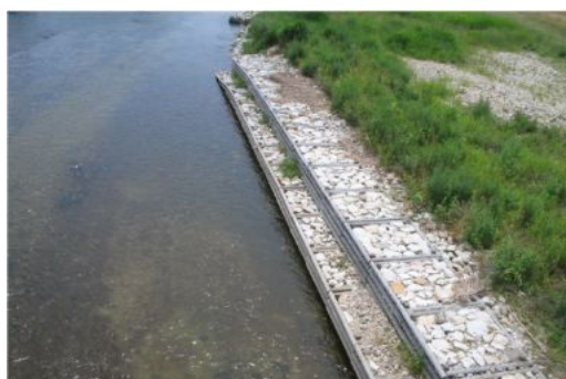
図-2.7 木工沈床の整備
