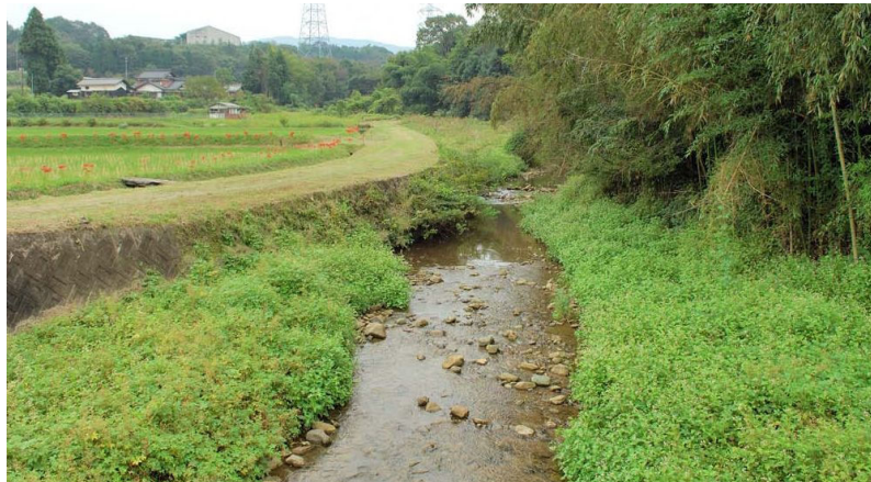
図-2.5 土岐川での改修事例－2（恵那市武並町竹折）
