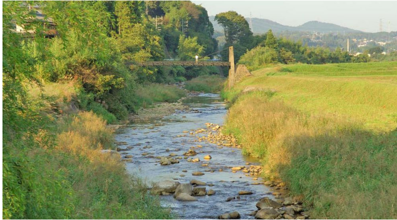
図-2.4 土岐川での改修事例－1（瑞浪市釜戸町）
