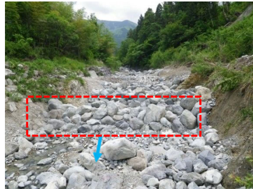
施工直後（石組み落差工）
