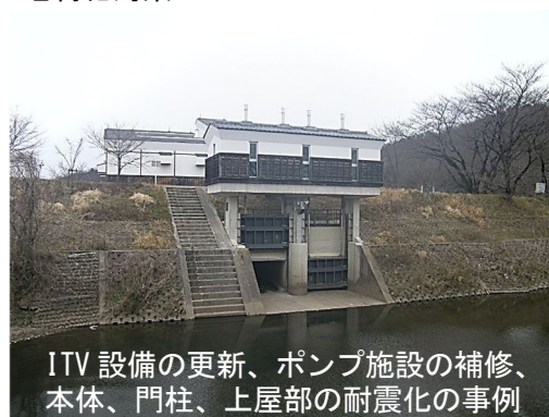
図- 1.30 上戸排水機場の老朽化対策・耐震化
