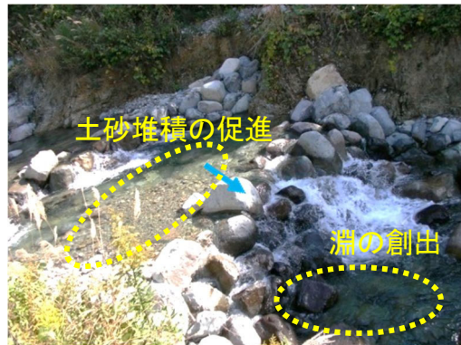
施工後（5ヶ月後）
