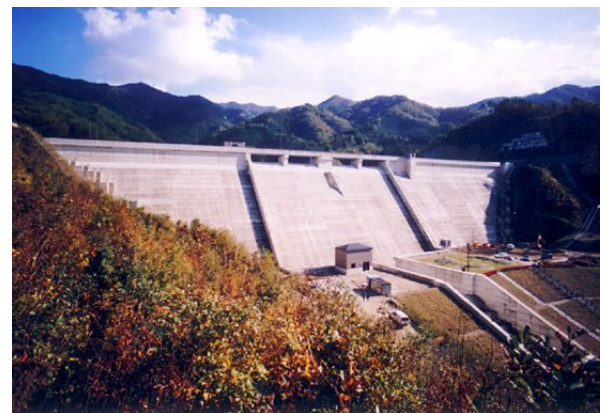
図- 1.18 大ヶ洞ダム
