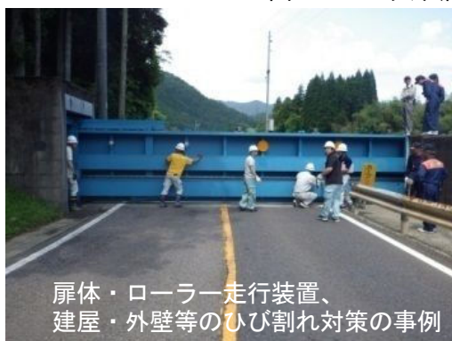
図- 1.29 妙見町陸閘の老朽化対策
