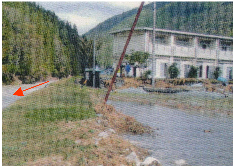
H16 馬瀬川(下呂市) 浸水状況
