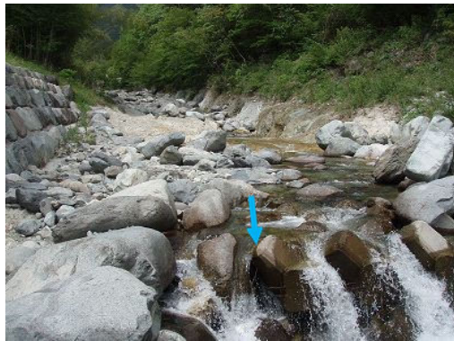
施工前（河床低下の進行）
