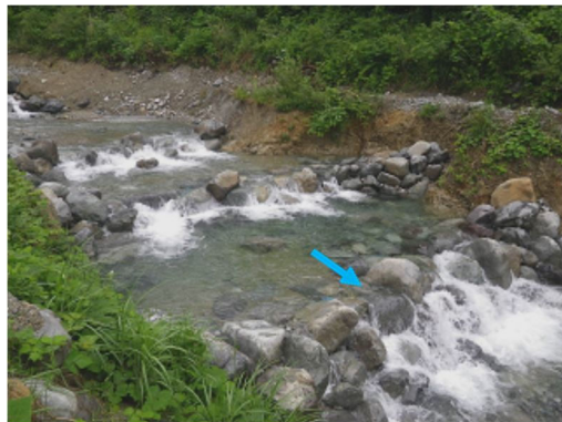
施工後（出水後）
