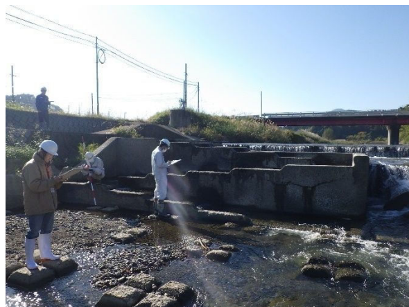
フィッシュウェイホーターによる魚道点検の状況
