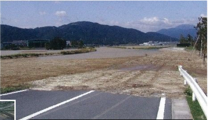
泥川 養老町室原 (泥川橋より上流)
