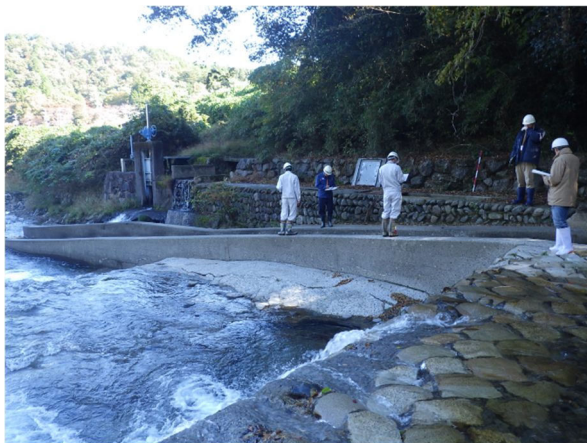
魚道カルテを用いた点検状況
