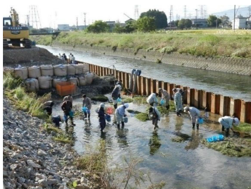
工事中の生物保護活動（杭瀬川）
