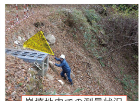
崩壊地内での測量状況
