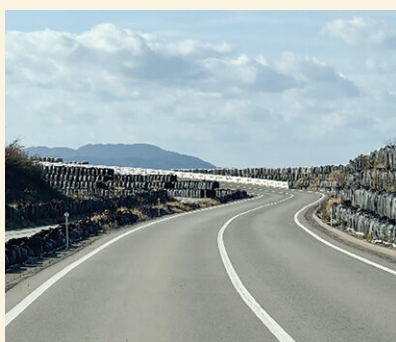
隆起した海岸を活用した仮設道 (路肩を土嚢で補強)
