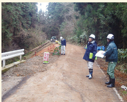
工事現場の様子
