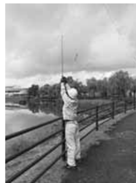
ため池の鳥よけ設置作業
