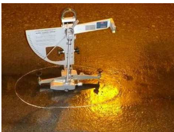
石灰分が付着しすべり抵抗の低下した路面
