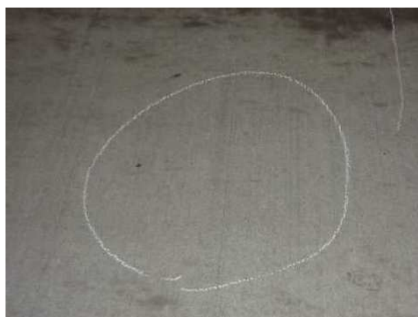
罫目が残っており健全な路面
