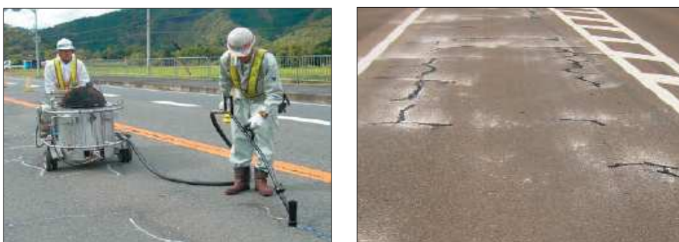
写真 6-1 シーリング材注入工法 施工例
