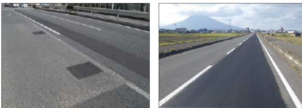
写真 6-2 パッチング工法 施工例
