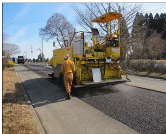
応力緩和層の施工状況
