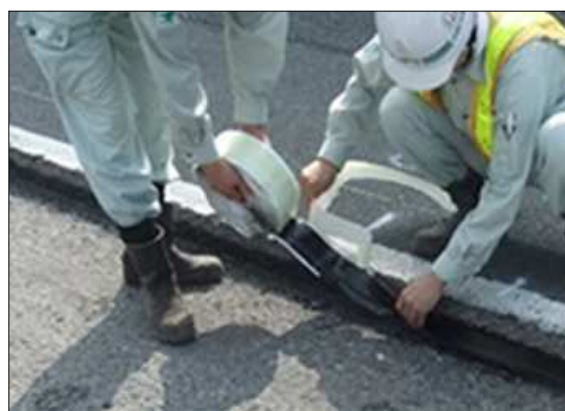
成型目地材の施工例
