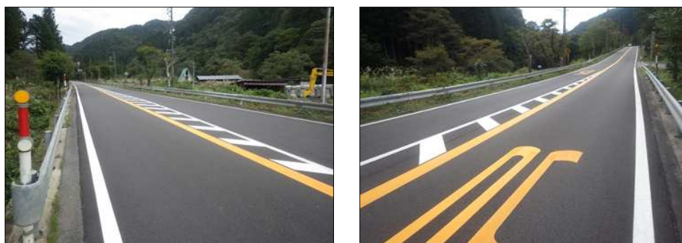
写真 6-3 特殊改質アスファルトを使用した薄層オーバーレイ工法の施工例 (一般国道 472 号 郡上市明宝奥住地内)
