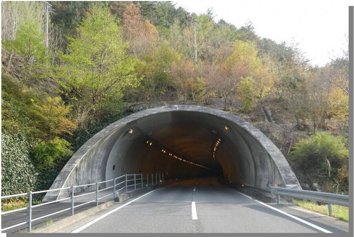
国道256号 高富トンネル上り線（山県市） 2002年建設
