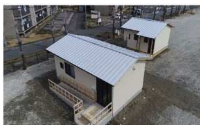
【木造応急仮設住宅】
