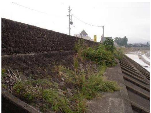
明治44年に長さ約250m、幅約20mの大改修を行い、玉石積堤防として完成。その後、幾度の大河による決壊や補強工事により、コンクリート造りに改修され現在に至る。
