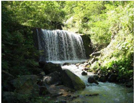
足洗谷上流標高約1,250mに、昭和7年9月から同9年11月にかけて、足洗谷筋における最初の砂防えん堤として、練石積コンクリート造りの第一えん堤が竣工。その後、下流部に第二号・三号が竣工。足洗谷第一号砂防えん堤は、70余年にわたり要の砂防えん堤として役割を果たし、足洗谷を守り続けている。
