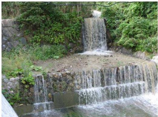
大正10年までに高さ4.5~7.3mの空石積えん堤14基が設置され、比較的堤高の低いえん堤が、段々に水を流し河道を安定化させている。周囲は植生がよみがえり、周囲の景観に砂防えん堤が見事に調和している。
