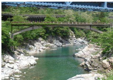
1930年頃スイスで活躍した橋りょう技師マイヤールが考案した近代的構造（マイヤール型）を採用した、昭和初期における国内唯一のマイヤール型RCアーチ橋。当時の最先端工法であり、従来型の橋りょうと比べ経済性に優れた構造となっている。
