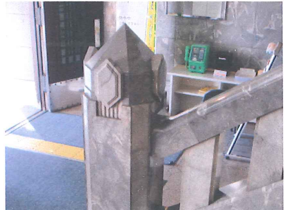
図 3-50 玄関ホール階段親柱
