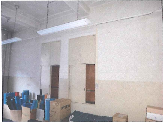
図3-33 収納として利用されている開口部
