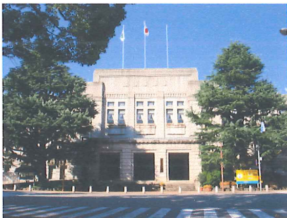
図2-4 第2代岐阜県庁舎(現岐阜総合庁舎)
