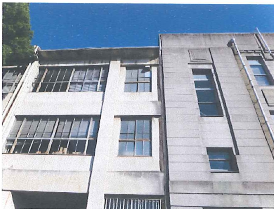
図 3-29 西面、増築部（左側）との連結箇所
