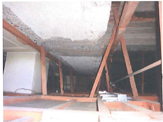
図3-36 旧議場傍聴席躯体の底面とそれを支える柱
