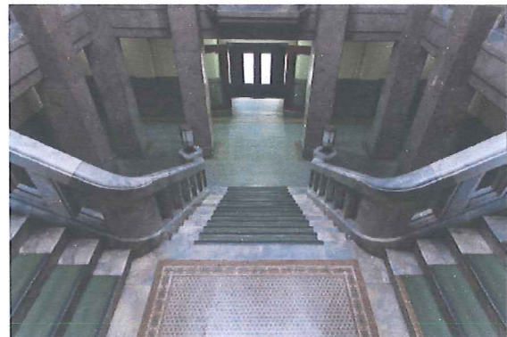
図 3-8 階段ホール2階床の常滑産タイル貼り
