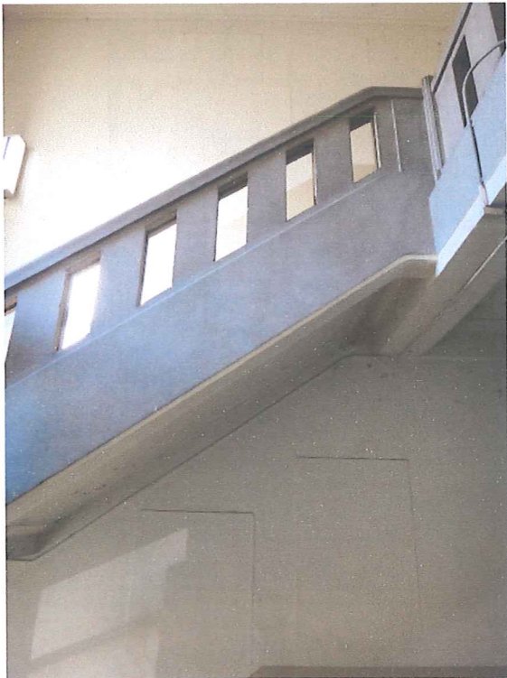
図3-34 開口部の痕跡(北西隅階段の北西2~3階)
