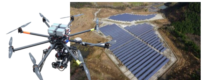
次世代太陽電池パネル保守点検技術
