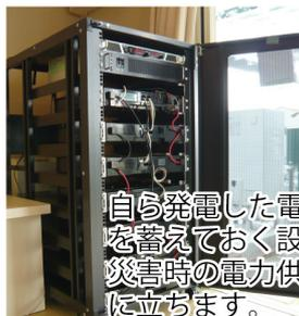
自ら発電した電気や商用電力を蓄えておく設備です。災害時の電力供給などにも役に立ちます。
