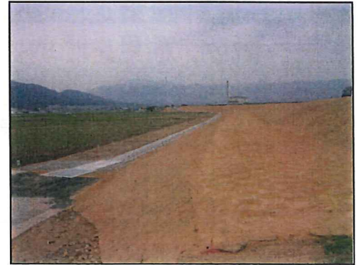
事業完了直後(堤防腹付け)
