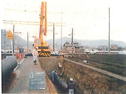
パイプライン敷設状況
