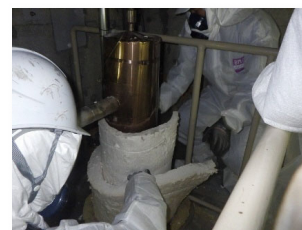
2次メンテナンス冷却系 保温設備の撤去作業
