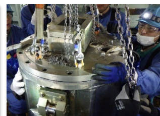
燃料交換装置の点検
