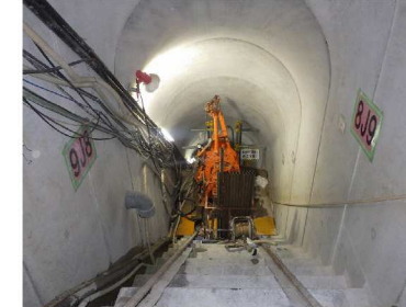
監査廊内基礎処理
