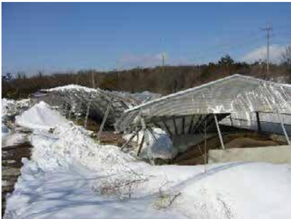
写真5 積雪による堆肥生産施設の倒壊
