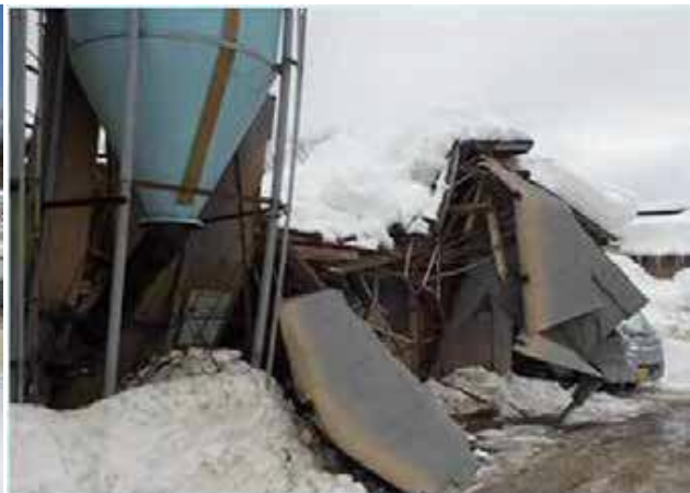
写真6 積雪による畜舎の倒壊
