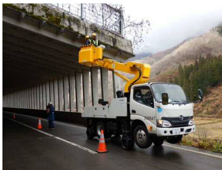
高所作業車による点検
