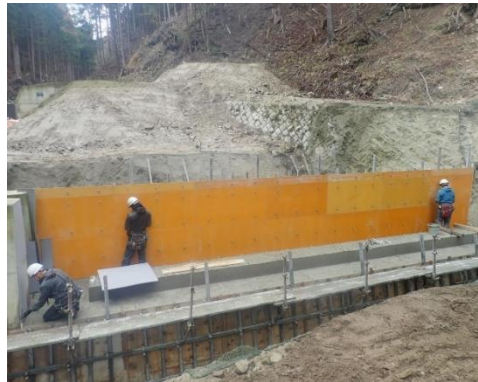
治山工事での県産材型枠 （恵那市）
