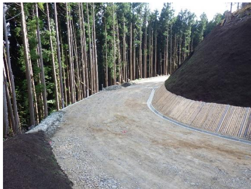
林道工事（丸太伏工） （郡上市）
