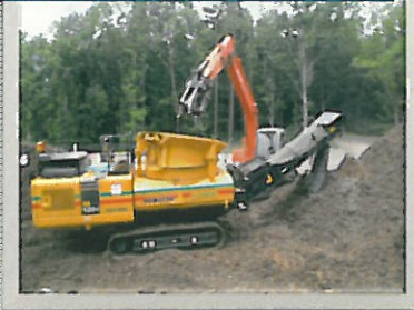
植生基材への利用(破碎状況)
