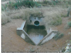
ほ場内沈砂池
