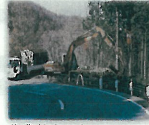
作業効率の向上 関ヶ原・八幡線春日・久瀬区間(揖斐川町)
