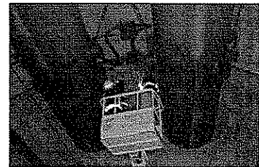
緊急点検の実施状況（H24.12月）
