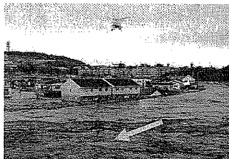
H24.7 白川（熊本県熊本市）の越水 （国土交通省 HP より）
