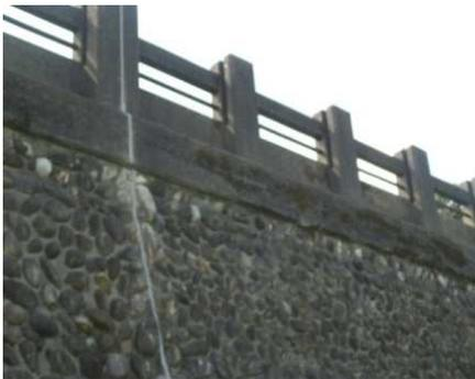
金華橋から忠節橋間の長良川左岸に位置する堤防。出水時に越水の危険がある時には、堤防の上部に畳を挟み込み、かさ上げできるような「角落とし構造」(写真下)になっている。(昭和15年完成)
