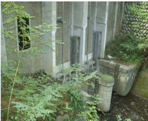
金華山山麓の鏡岩に取り入れ口を有する農業用水。忠節用水第2樋門は、昭和8年に建設後、平成4年度にゲートが取替られたが、樋管側壁は当時の面影を偲ばせる。
