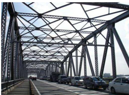
昭和8年建設当時、岐阜市と大垣市を結ぶ鉄道との供用橋として計画。このため部材が重厚でリベット（鋼材を締結するのに用いる金属製の機械部品）が多く使われており、力強い景観となっている。鉄道を走らせる予定であった橋の南（下流側）と北（上流側）では下部構造が異なる。
