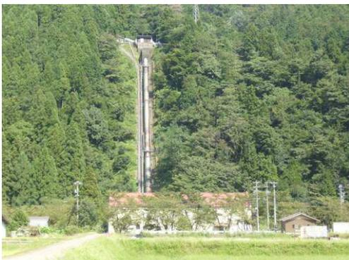
本業市根尾長島にある水力発電所。大正12年に運用が開始され、有効落差約82m、認可最大出力は4,500 kW、発電方式は自流水路式の水力発電所。発電所の付近には、大正11年に国の天然記念物に指定され、日本三大桜にも数えられている樹齢千数百年の薄墨桜がある。
