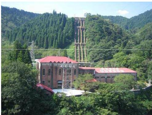
揖斐郡揖斐川町にある水力発電所。大正10年に運用が開始され、認可最大出力は12,100 kW、発電方式は自流水路式の水力発電所である。
