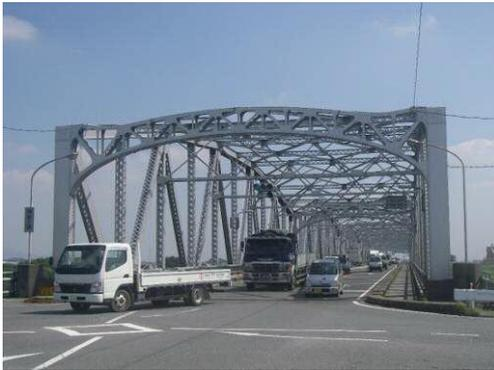
昭和8年に大垣市と安八町を結ぶ揖斐川に架設されたトラス橋。当初は、橋りょうの北(上流側)を道路用、南(下流側)を鉄道用とする併用橋として建設されたが、昭和39年に道路橋として供用された。現在も、橋りょうの南と北では下部の構造が異っており、併用橋の名残がある。
