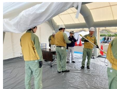
拠点の設営作業
