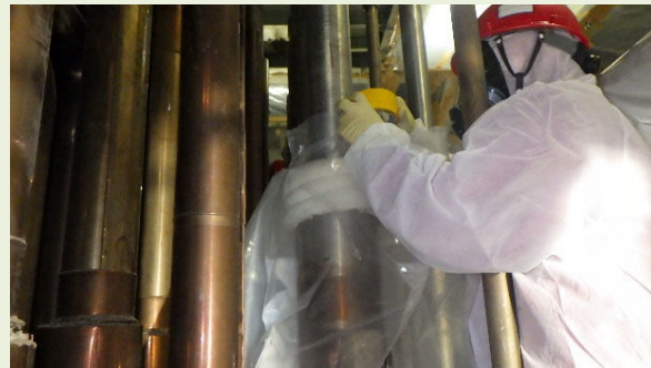
制御棒案内管の解体撤去
