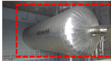
低圧第1、2給水加熱器 (解体撤去前)
