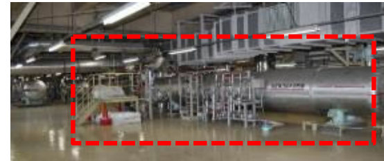
低圧第3給水加熱器 (解体撤去前)
