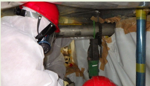
炉上部配管の解体撤去
