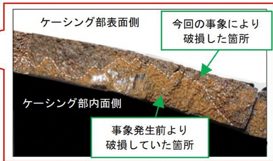
＜ケーシング部き裂断面＞
