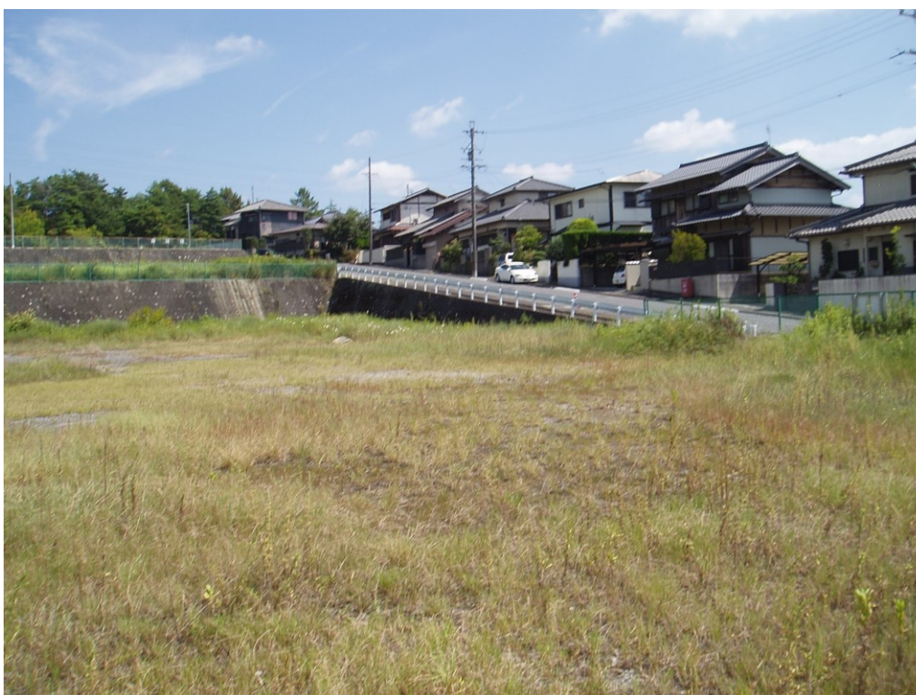
物件西方向から東方向を撮影（正面が1番2）
