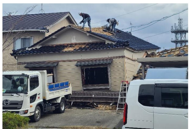
解体中の被災家屋
