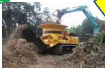
(木質ペレット、チップ製造施設)
