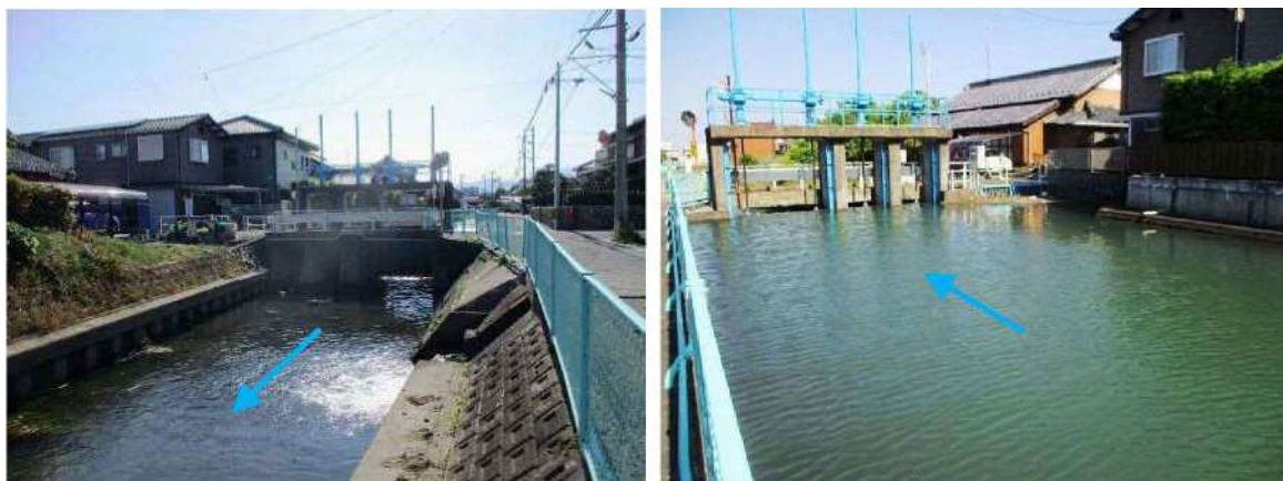
図 2-4 八島樋門の状況
