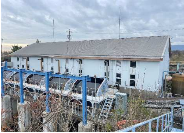
图 2-5 水門川排水機場
