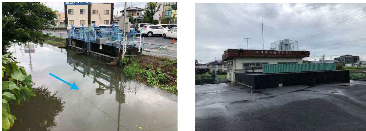
図 2-2 水門川上流排水機場
