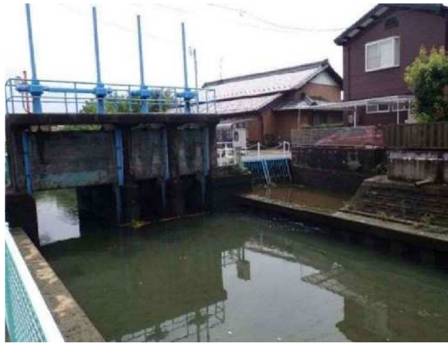
图 3-11 八島樋門(開扉狀況)
