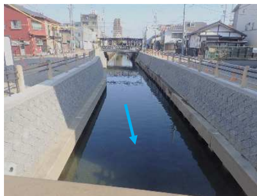
図 3-2 改修済区間の状況
