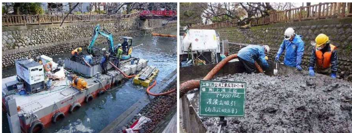
図 2-9 河床掘削状況
