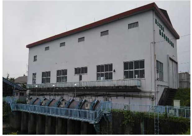
图 2-6 新水門川排水機場
