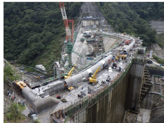
プレキャスト水平監査廊(左岸上流側から望む)
