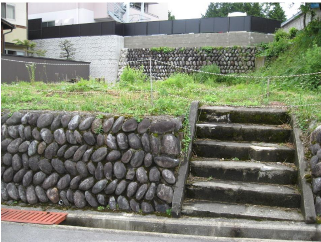
物件南西方向から撮影
