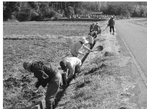
水路の泥上げ（垂井町）
