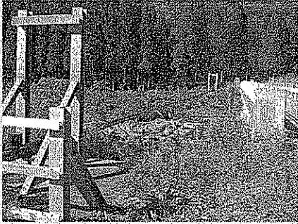
簡易水道施設
