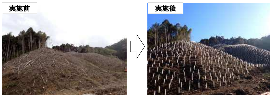
事業実施箇所の整備状況(関市中之保音戸)
