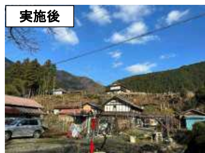
事業実施箇所の整備状況（本巢市）
