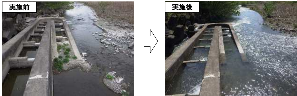
魚道の改善状況(大垣市 藤古川)
