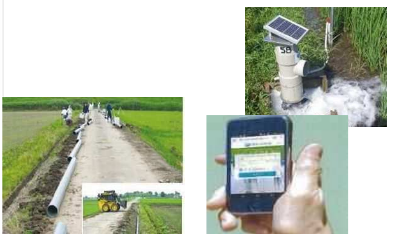
水路の管路化
