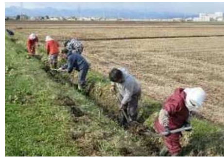
水路の泥上げ
