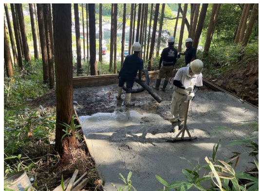
基礎コンクリート打設
