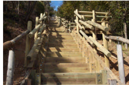
「みのかも健康の森」遊歩道再整備
