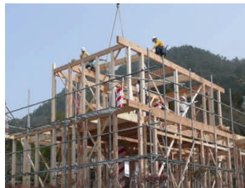
県産材住宅の上棟
