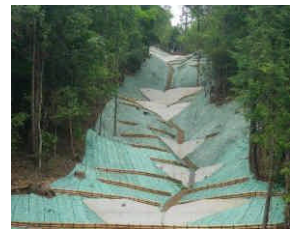
災害関連緊急治山施工地（八百津町）
