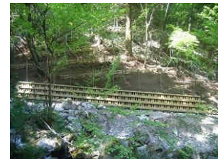
泡沫ブロックを使用した治山工事(下呂市)
