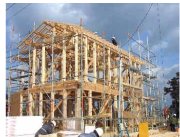
県産材住宅の建設現場
