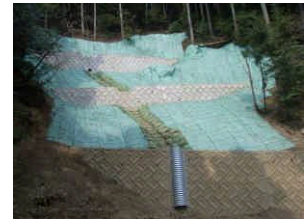
山腹整備状況（垂井町）
