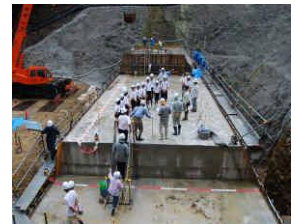
治山工事見学会の様子（白川町）
