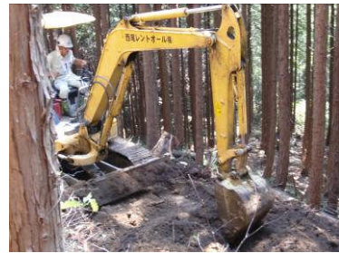
作業道開設実習
