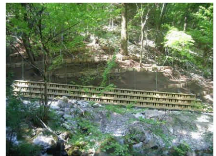
木製土留め（下呂市）
