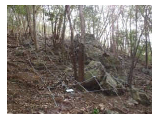
治山事業による落石対策（関市）
