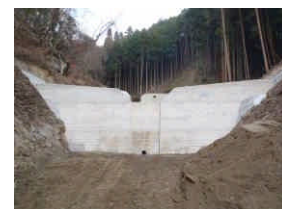
谷止工の施工(瑞浪市)
