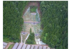
崩壊地の復旧を図る山腹工（高山市）
