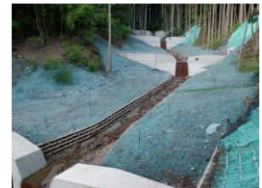
治山施工現場（恵那市）
