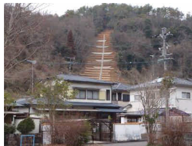
復旧状況 (H23. 2)
