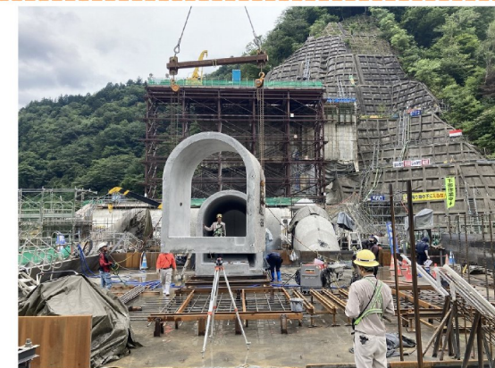
プレキャスト水平監査廊設置
