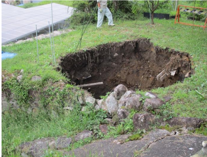
陥没箇所②
