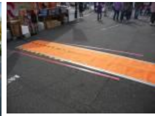
電気配線カバー
