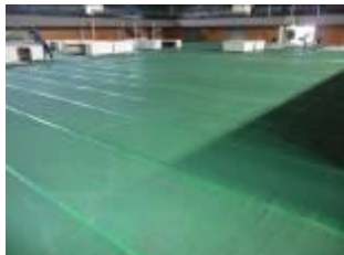
アリーナ床面養生
