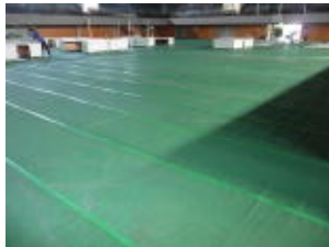
アリーナ床面養生
