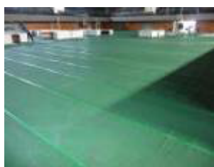
アリーナ床面養生
