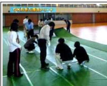
アリーナ床面養生
