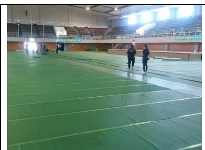
設営（アリーナ床養生）
