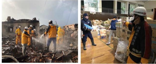
【出典：R6. 4. 15 令和6年能登半島地震に係る検証チーム(第3回)「令和6年能登半島地震における各省庁の避難所運営等に係る対応状況」】
