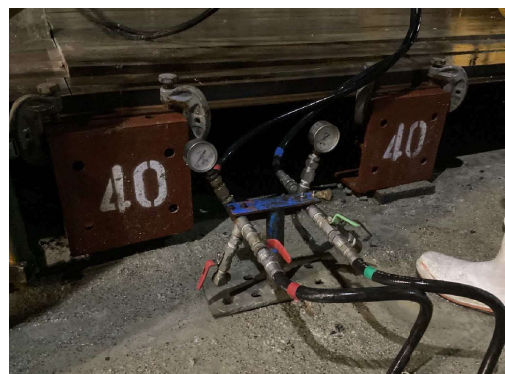
注入圧の確認状況
