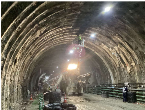
トンネル全体の状況
